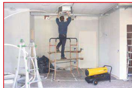
Secado de obras
